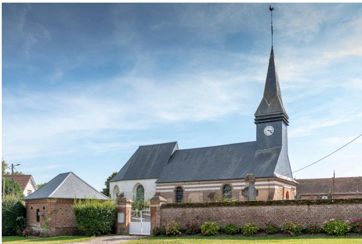
Vue d'ensemble de l'église, avec le bâtiment des pompes et l'entrée du cimetière (depuis le nord-ouest).
