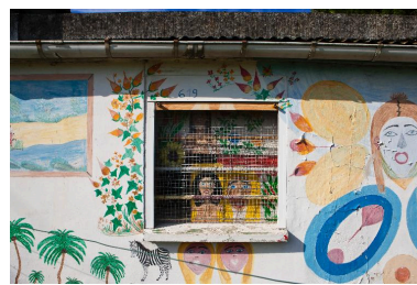
Mur gouttereau : détail avec une fenêtre.
