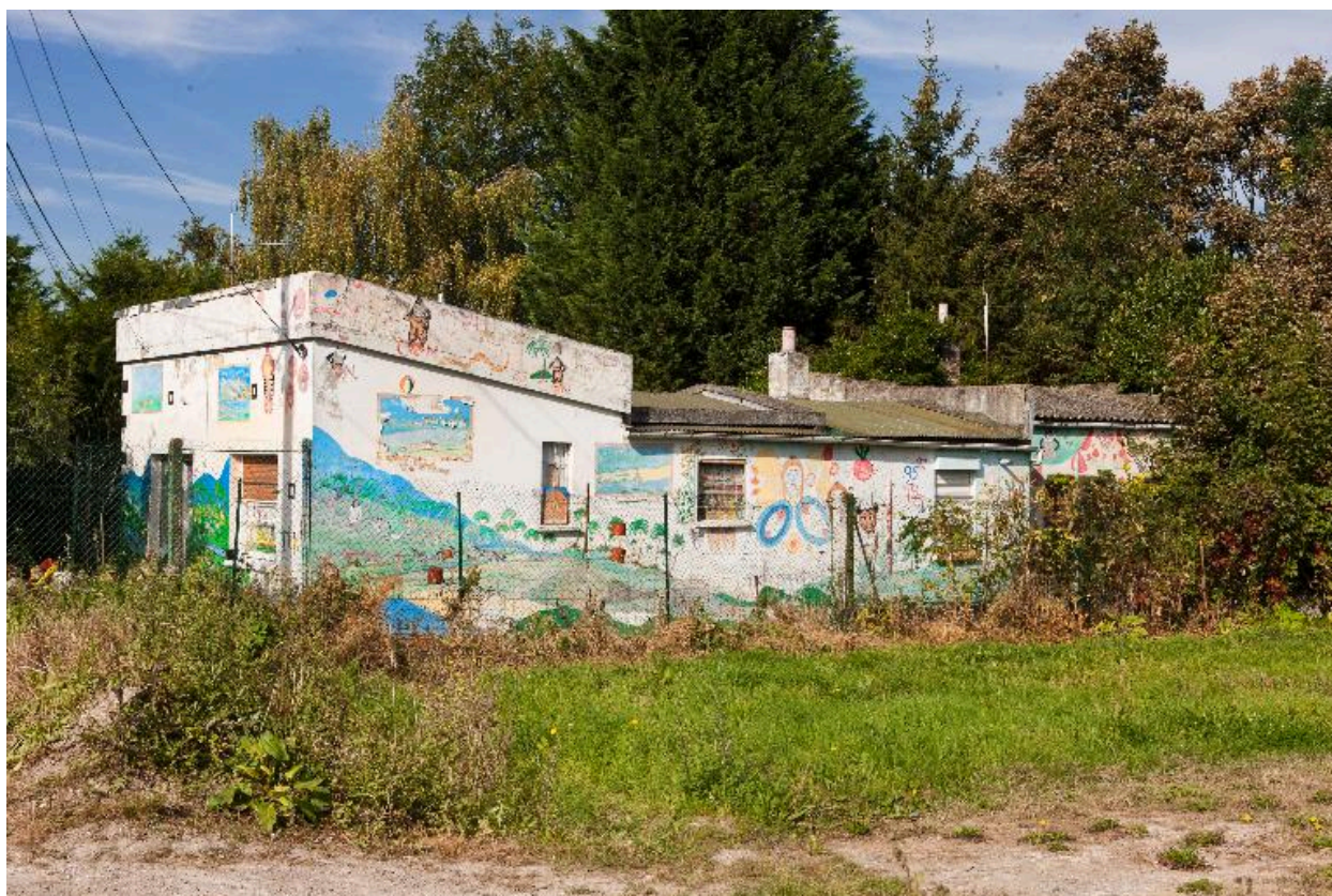
Vue de trois quarts depuis la rue.
