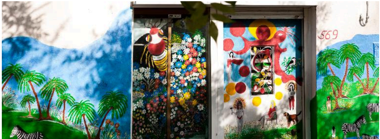
Façade, détail : fenêtre et porte.
