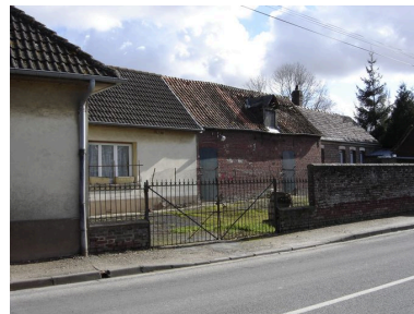
Vue des écuries. Phot. Inès Guérin IVR22_20058005257NUCA
