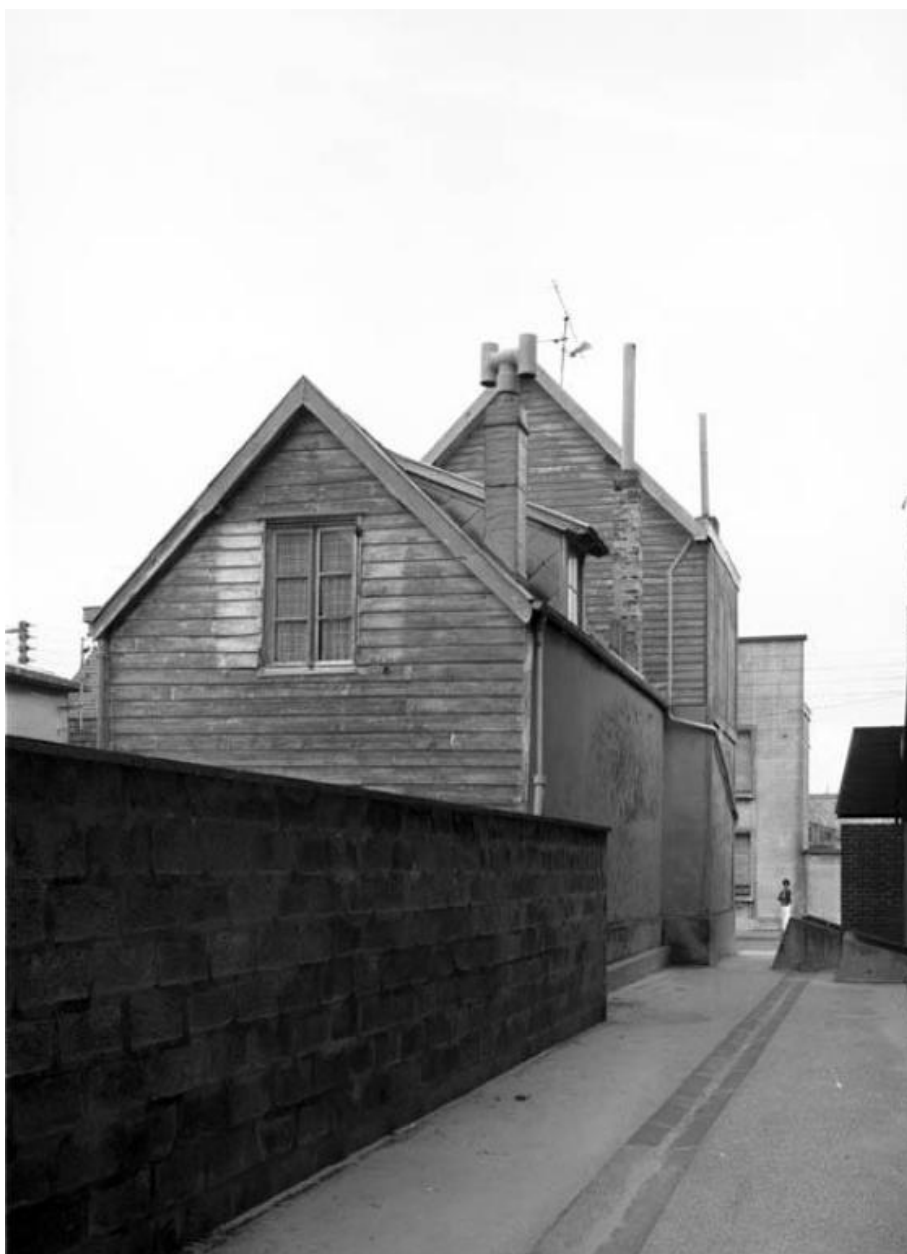
Façades postérieure et latérale gauche.
