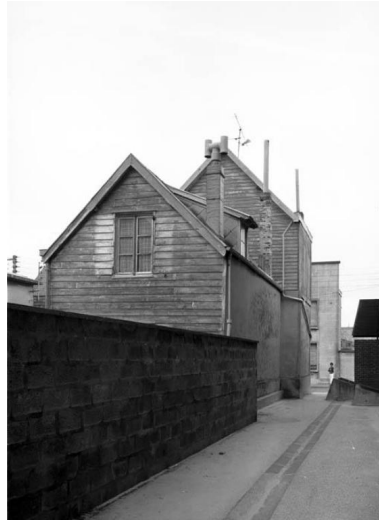
Façades postérieure et latérale gauche. Phot. Philippe Caudroit IVR31_19816203628X
