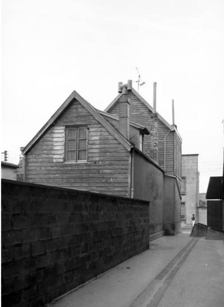
Façades postérieure et latérale gauche.
