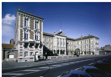
Vue générale. Phot. Thierry Lefébure IVR22_20038000617PA
