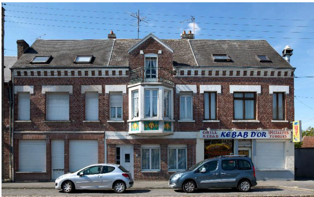
Maison, 34 à 38 rue de Noyon.
