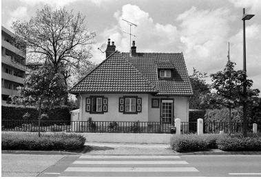
Vue de la façade sur rue. Phot. Pierre-Yves Brest IVR22_19990202055Z
