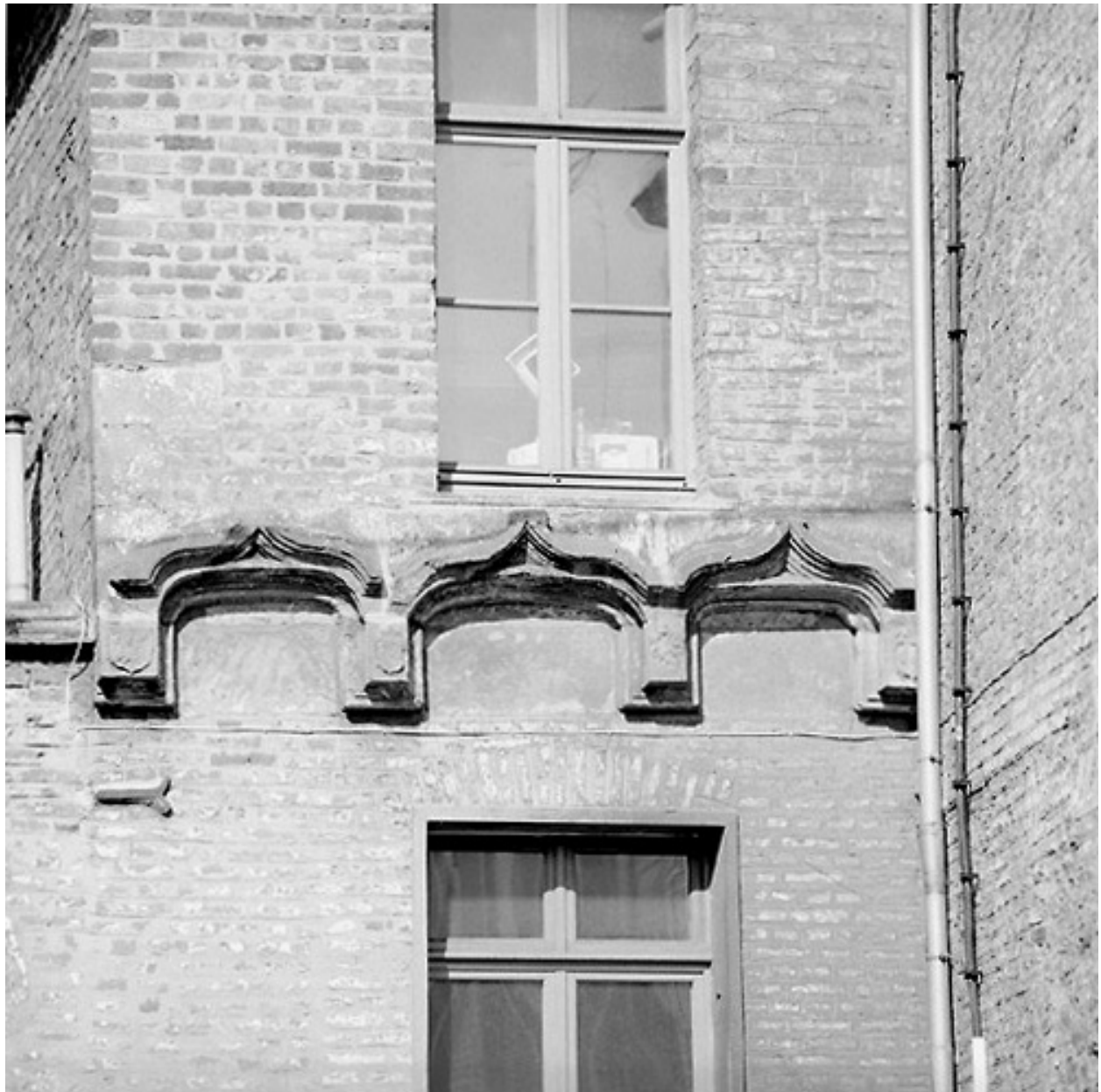
Corps de bâtiment de plan carré, détail : arcature.
