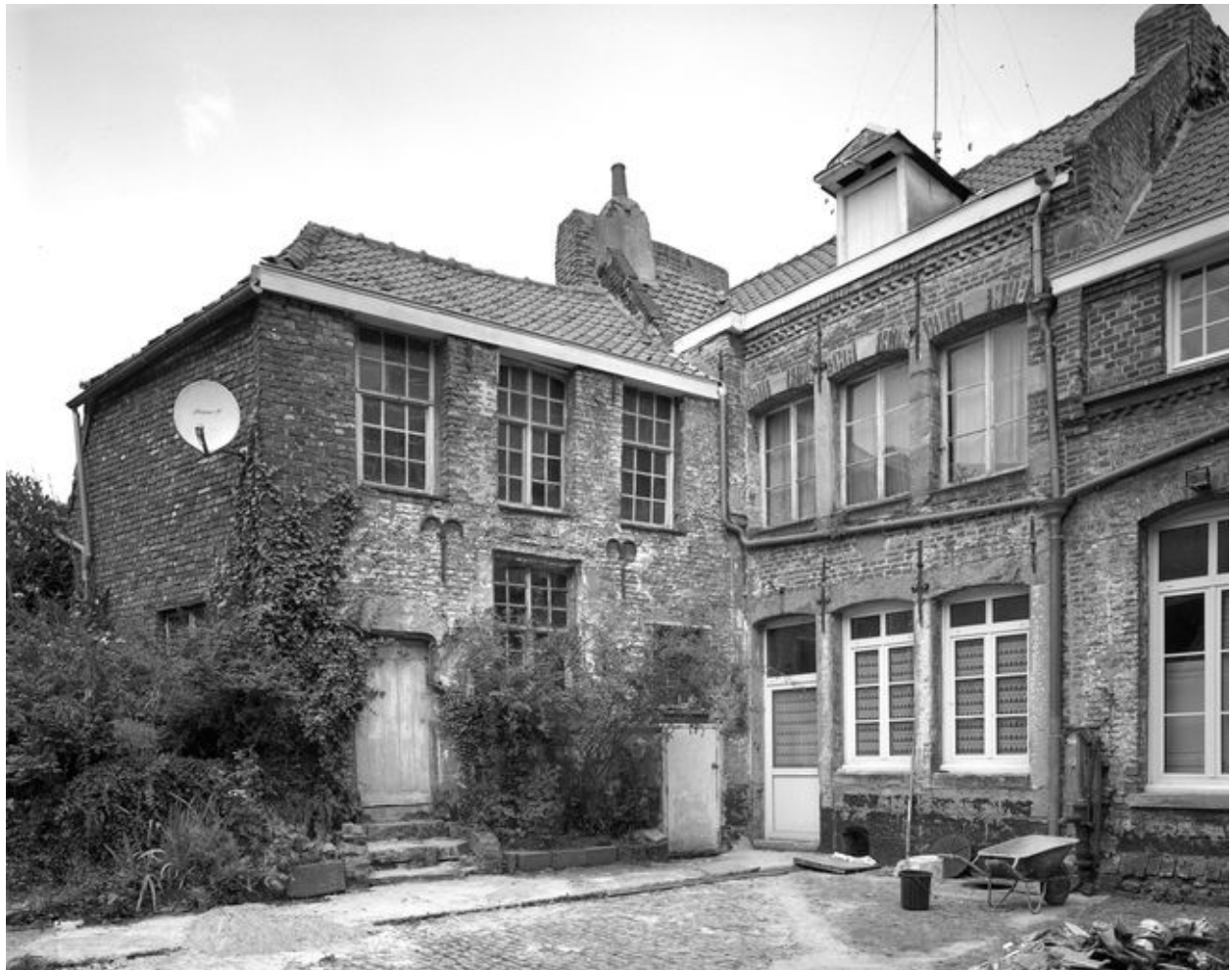
Aile en retour et aile nord-ouest sur cour, vue générale (état en 2003).
