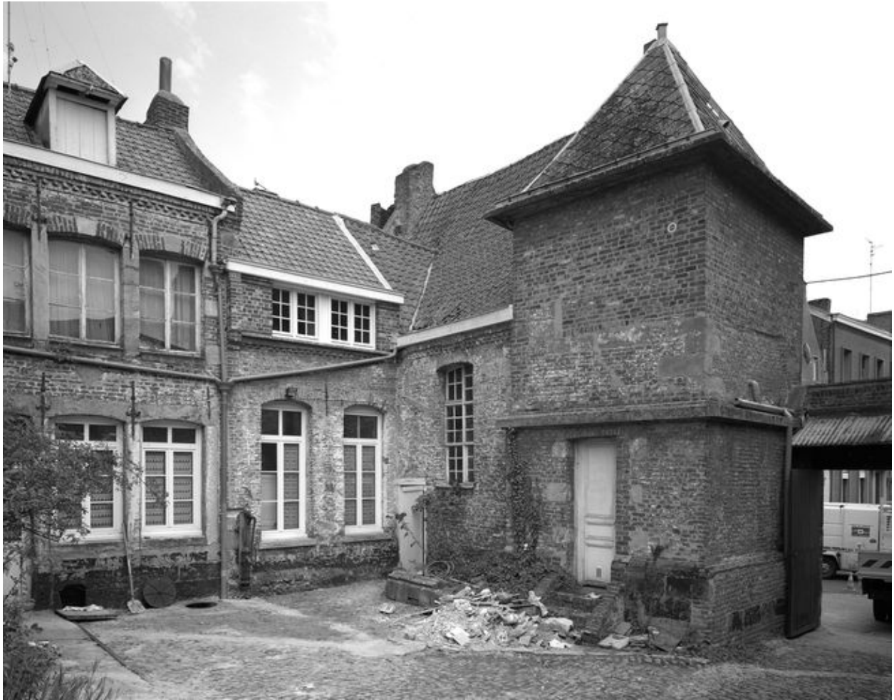
Façade arrière et aile en retour sur cour, vue générale (état en 2003).
