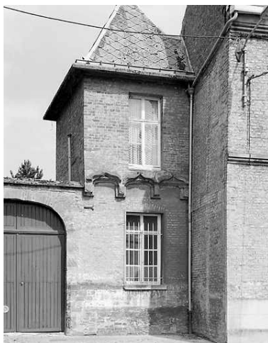
Corps de bâtiment de plan carré situé à gauche du corps de logis principal. Phot. Pierre Thibaut IVR31_20025901268V
