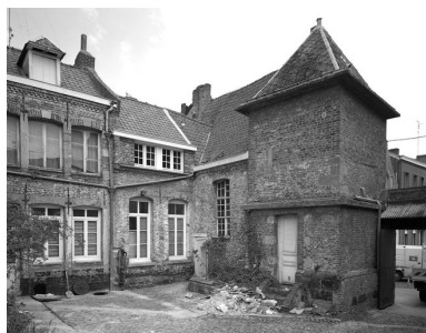
Façade arrière et aile en retour sur cour, vue générale (état en 2003). Phot. Pierre Thibaut IVR31_20035900783V
