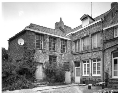
Aile en retour et aile nord-ouest sur cour, vue générale (état en 2003). Phot. Pierre Thibaut IVR31_20035900784V
