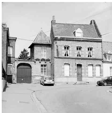
Vue générale rue du Collège. Phot. Pierre Thibaut IVR31_20015901223X
