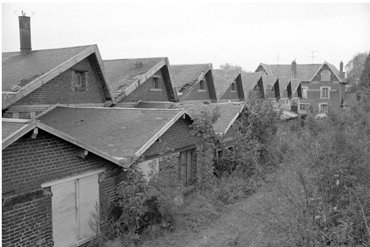
Atelier de fabrication, flanc est.
