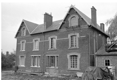
Logement patronal, élévation postérieure.
