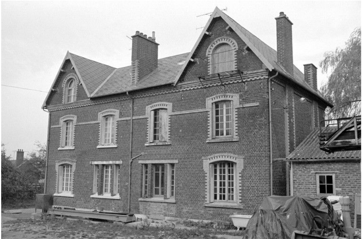
Logement patronal, élévation postérieure.
