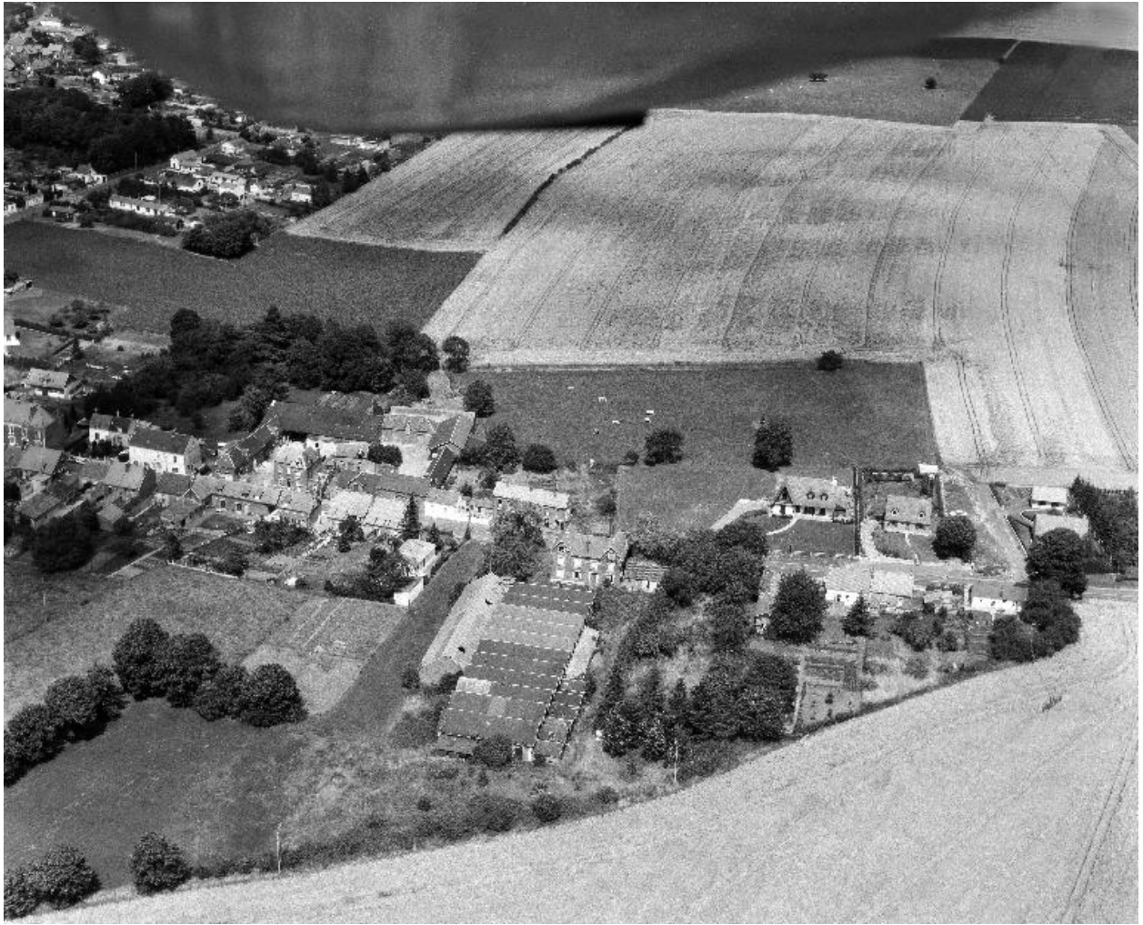
Vue aérienne, flanc sud.
