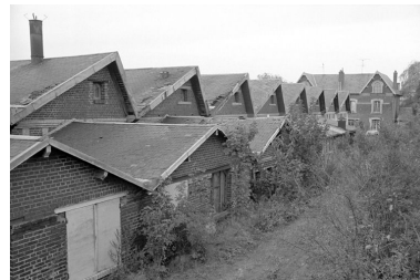
Atelier de fabrication, flanc est.
