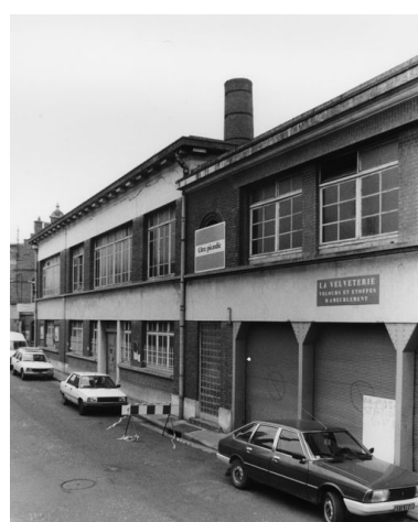
Vue partielle, flanc est.
