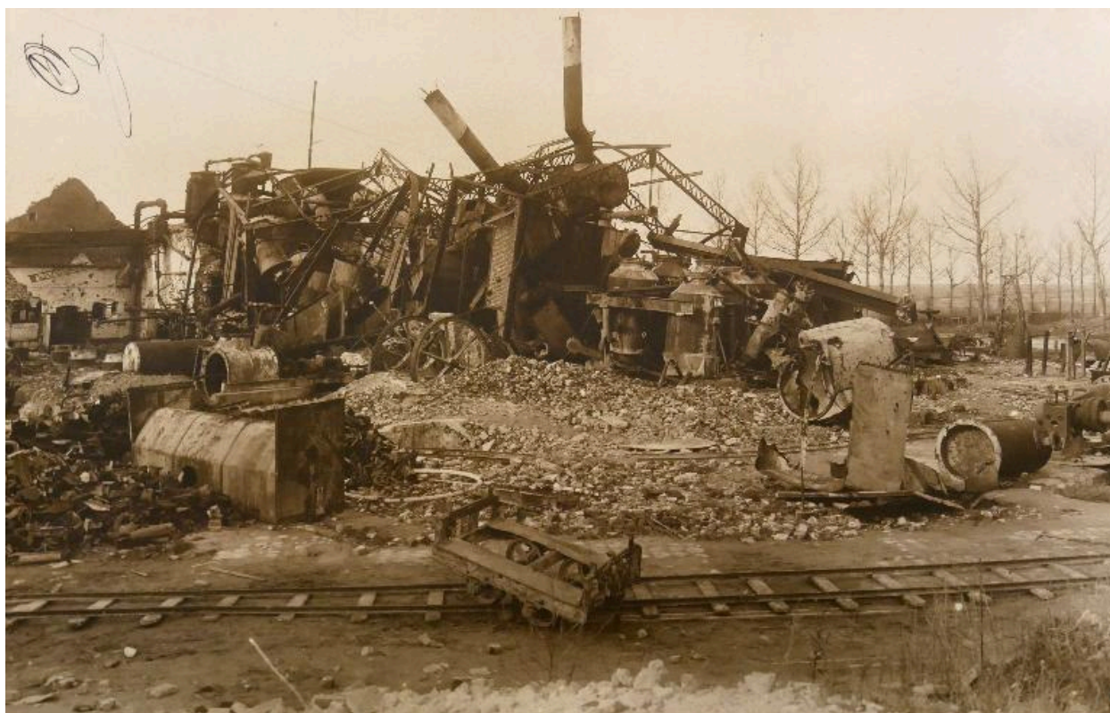
Vue générale de la sucrerie en ruine en 1919. (AD Aisne ; 15 R 1819/1).
