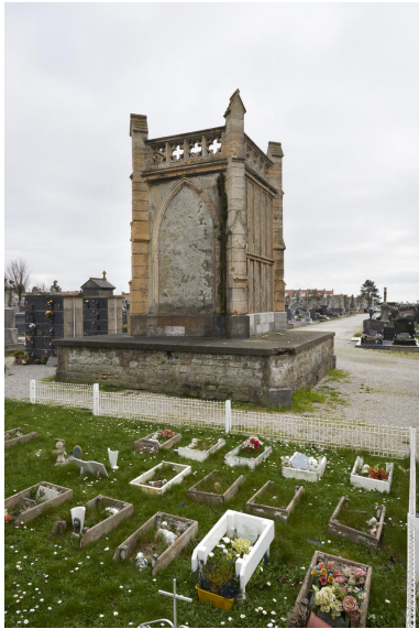
Vue de la façade nord. Phot. Delphine Volto-Jourdan IVR32_20246200088NUCA
