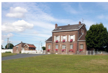
Vue de la façade est. Phot. Thierry Lefébure IVR22_20038000712NUCA
