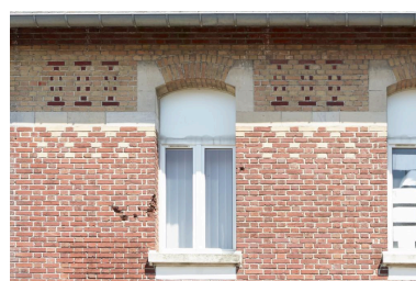
Détail du décor de brique des façades. Phot. Delphine Volto-Jourdan IVR32_20216200633NUCA
