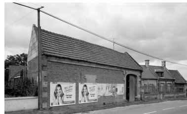
Grange. Elévation sur rue. Phot. Jean-Michel Perrin IVR22_19856000997X
