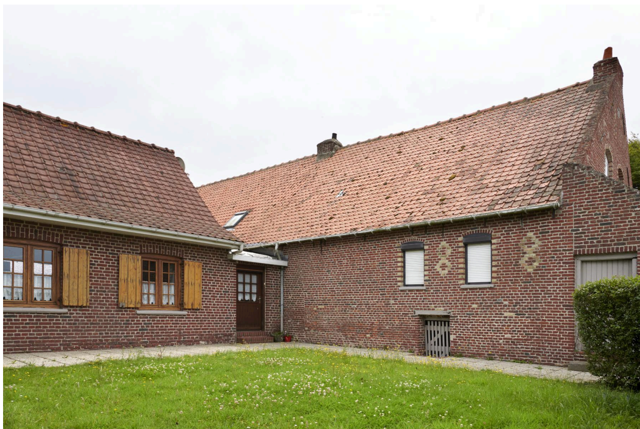
Logis, depuis l'ouest (rue Principale).
