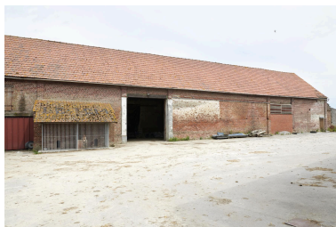
Bâtiment au nord de la ferme. Phot. Delphine Volto-Jourdan IVR32_20245902656NUCA
