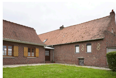
Logis, depuis l'ouest (rue Principale). Phot. Delphine Volto-Jourdan IVR32_20245902657NUCA
