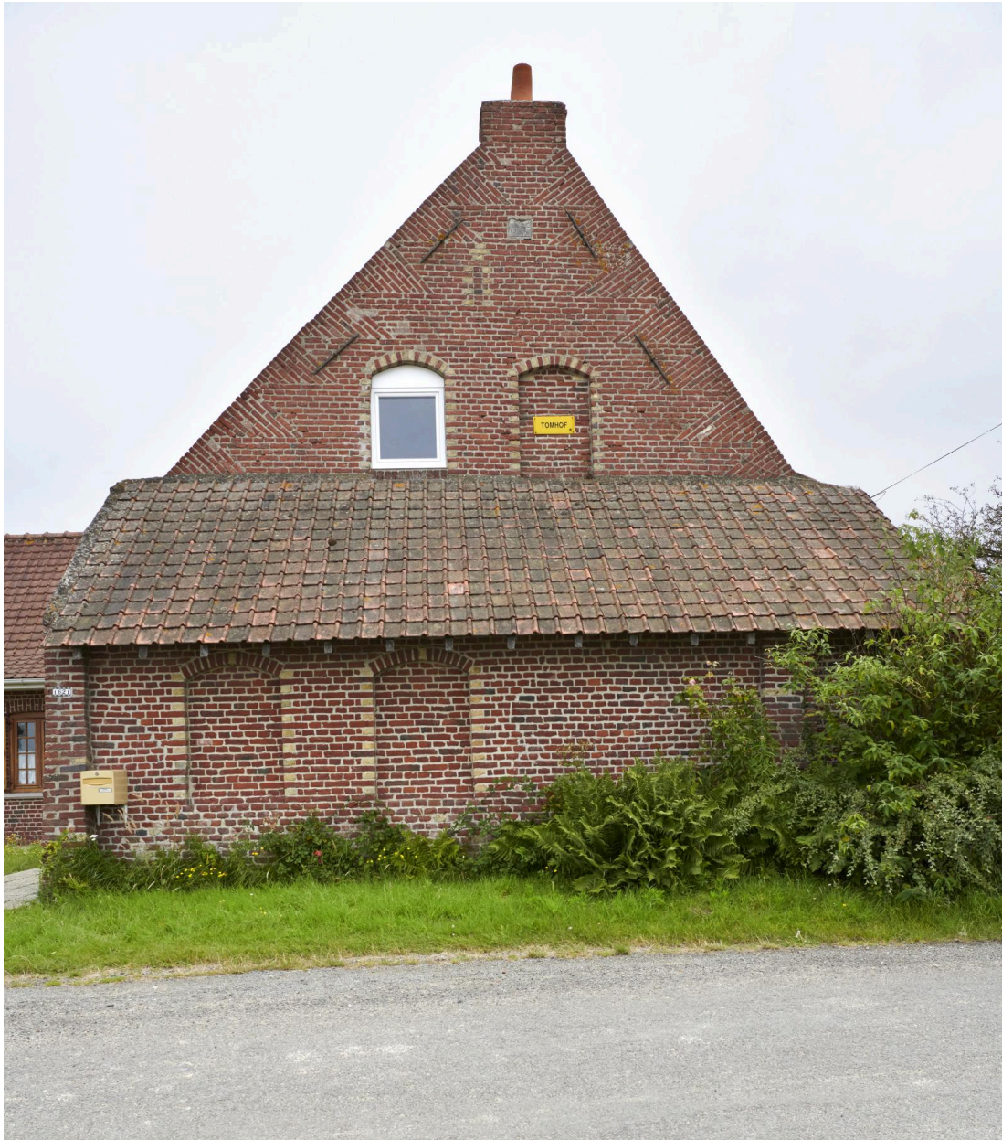
Pignon ouest et appentis adossé, sur rue.
