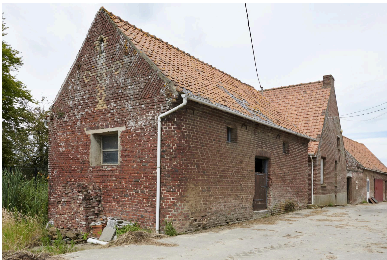
Alignement composé du logis principal (au centre) et de l'extension sud (au premier plan).
