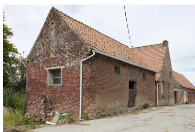
Alignement composé du logis principal (au centre) et de l'extension sud (au premier plan). Phot. Delphine Volto-Jourdan IVR32_20245902652NUCA
