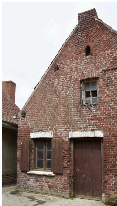
Pignon sur arrière-cour, accès au logis. Phot. Delphine Volto-Jourdan IVR32_20245902655NUCA
