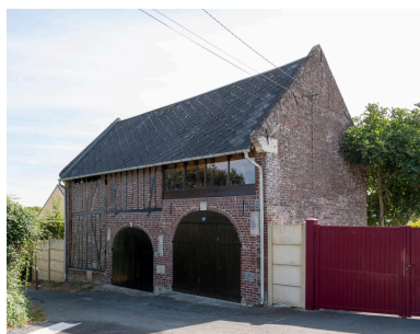
Ancienne grange remaniée, n°10 impasse Charles Mesnard, vue depuis l'ouest. Phot. Marc Kérignard IVR32_20226000867NUCA
