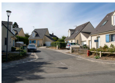
Lotissement des vignes, vue depuis le nord. Phot. Marc Kérignard IVR32_20226000866NUCA
