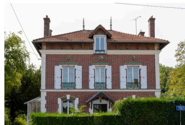
Maison de notable, n°2 rue Marcel Dassault, vue depuis le nord. Phot. Marc Kérignard IVR32_20226000862NUCA
