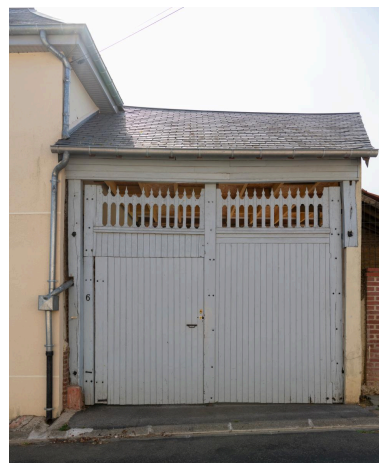
Entrée charretière, n°6 rue Marcel Dassault, vue depuis le nord. Phot. Marc Kérignard IVR32_20226000864NUCA
