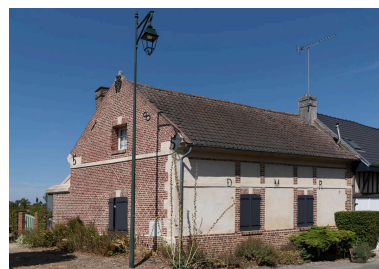
Maison avec date portée de 1855, n°6 rue du Château, vue depuis le sud. Phot. Marc Kérignard IVR32_20226000870NUCA
