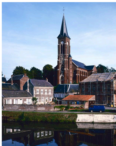
Vue d'ensemble, depuis le sud-ouest. Phot. Thierry Lefébure IVR22_19910202028ZA
