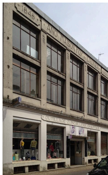
Vue du magasin. Phot. Isabelle Barbedor IVR22_20158006203NUCA
