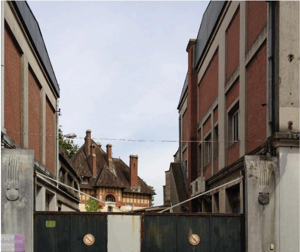
Le portail et le passage donnant accès aux magasins et à la demeure.
