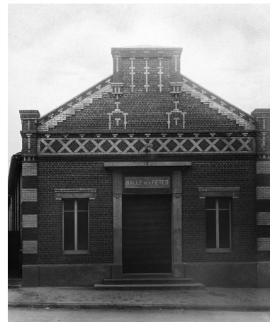
Façade sur rue de la salle des fêtes, photographie Charles Jamin architecte, [s.d.] (coll. part.). Phot. Thierry Lefébure IVR22_19990204630XB
