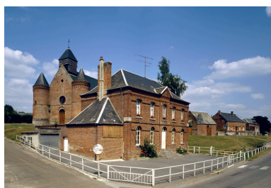
Vue des bâtiments bordant le côté nord de la rue du Général-de-Gaulle (d'ouest en est). Phot. Thierry Lefébure IVR22_19930200889VA
