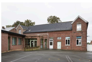
Façade sur cour. Aile est. Phot. Delphine Volto Jourdan IVR32_20255901126NUCA
