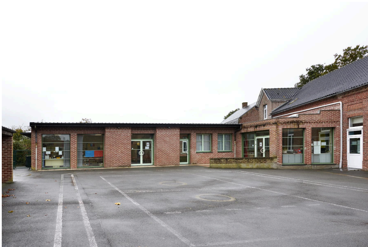
Vue générale de la cour (extension XXe siècle).
