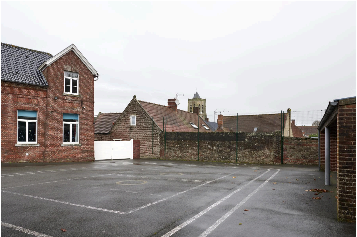
Vue générale de la cour vers l'église en arrière-plan.
