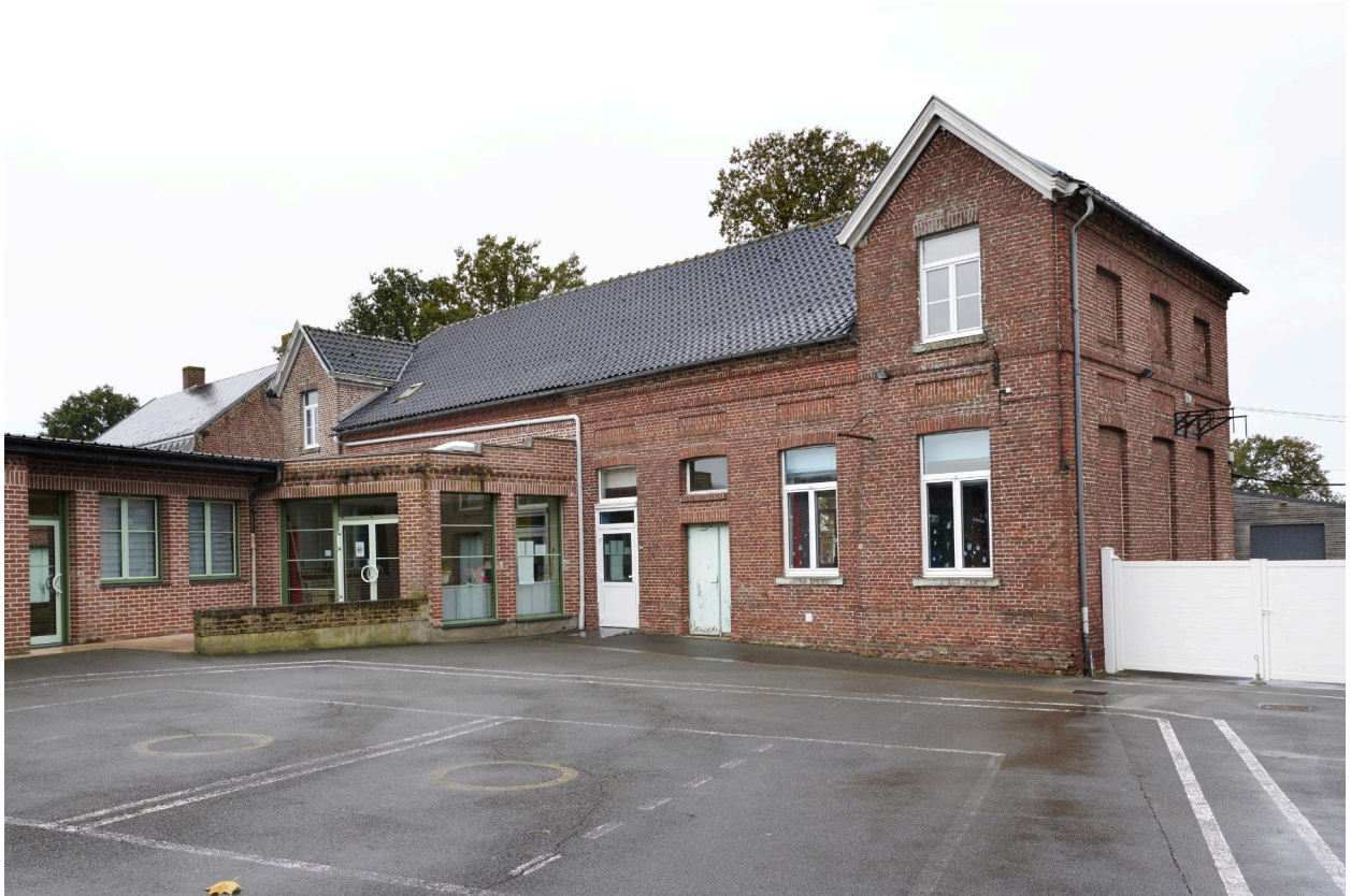
Bâtiment principal, façade sur cour.
