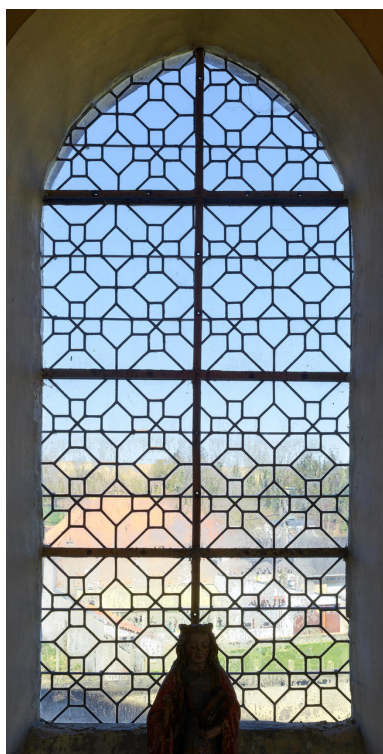
Verrière (baie 9) : verrière à borne.
