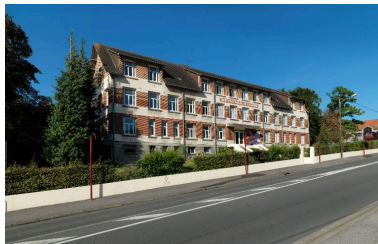
Vue d'ensemble sur rue. Phot. Thierry Lefébure IVR22_20128000604NUC2A
