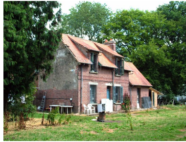
Maison forestière dite Maison Rouge, en lisière du bois de Ribeaucourt à Fransu. Phot. Frédéric Fournis IVR22_20108001903NUCA
