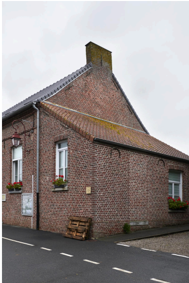
Détail de l'extension à l'est de l'édifice.
