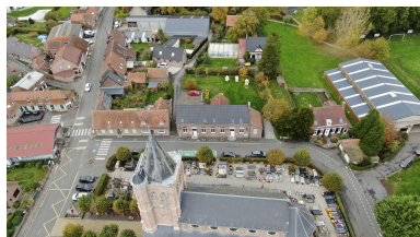
Vue aérienne de l'école, au nord de l'église. Phot. Delphine Volto Jourdan IVR32_20255901415NUCA
