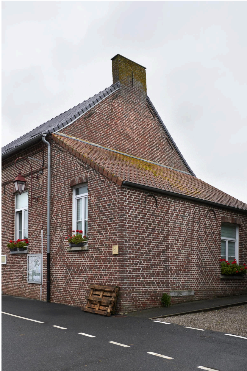
Détail de l'extension à l'est de l'édifice.
