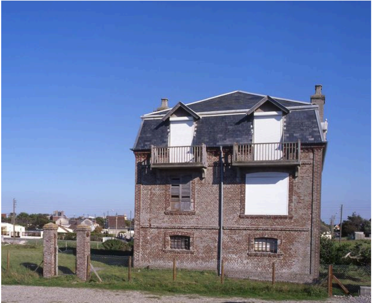
Elévation côté mer.
