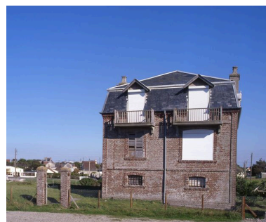
Élévation côté mer. Phot. Marie-Laure Monnehay-Vulliet IVR22_20048000145XA
