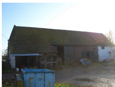
Vue de la grange depuis la cour. Phot. Inès Guérin IVR22_20078005028NUCA
