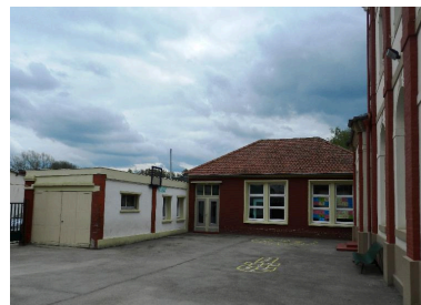
Vue de la nouvelle salle de classe et du bâtiment occupant l'emplacement de l'ancienne étable et de la buanderie. Phot. Romain Grimaud IVR22_20128015566NUCA
