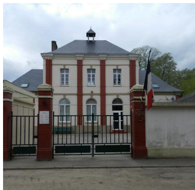
Vue du portail de l'ancienne école, seul le passage piéton de gauche a été conservé. Phot. Romain Grimaud IVR22_20128015567NUCA
