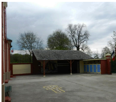
Vue du préau et des sanitaires. Phot. Romain Grimaud IVR22_20128015565NUCA
