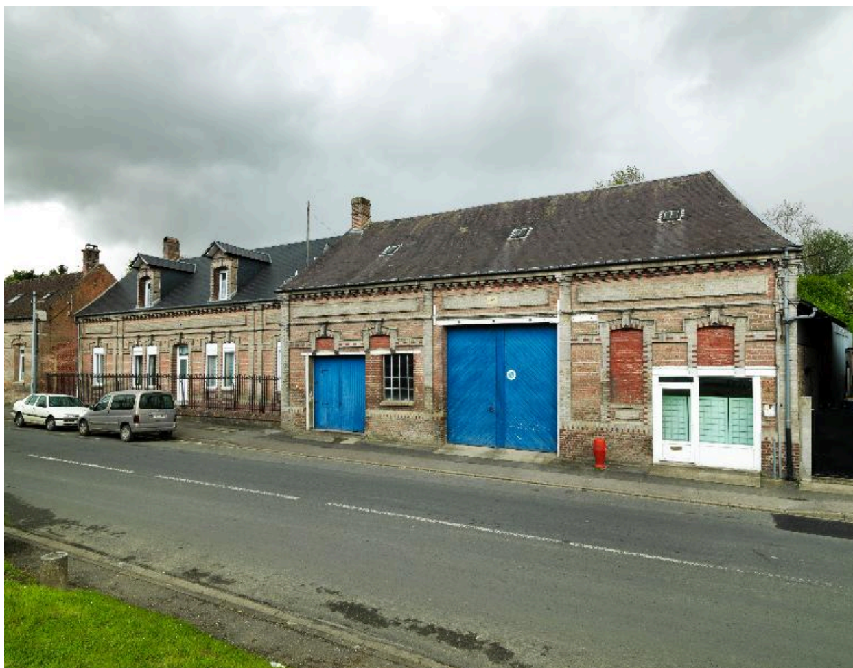
Vue d'ensemble sur rue.
