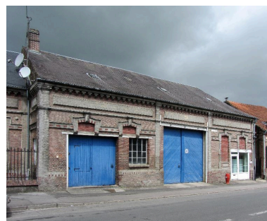
Façade sur rue des dépendances et de l'entrée charretière. Phot. Bertrand Fournier IVR22_20138015823NUC2AQ
