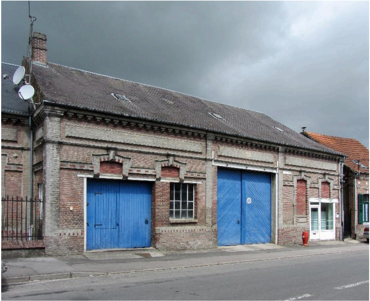
Façade sur rue des dépendances et de l'entrée charretière.
