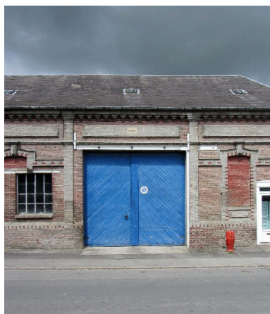
Façade sur rue de l'entrée charretière. Phot. Bertrand Fournier IVR22_20138015824NUC2AQ
