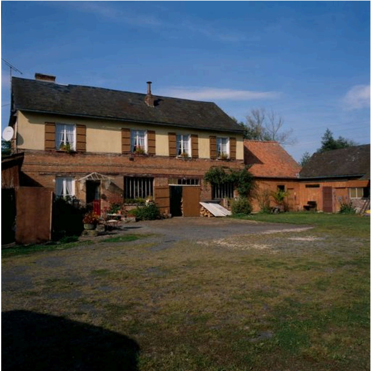
Façade sur cour du logement et de l'atelier contigu.
