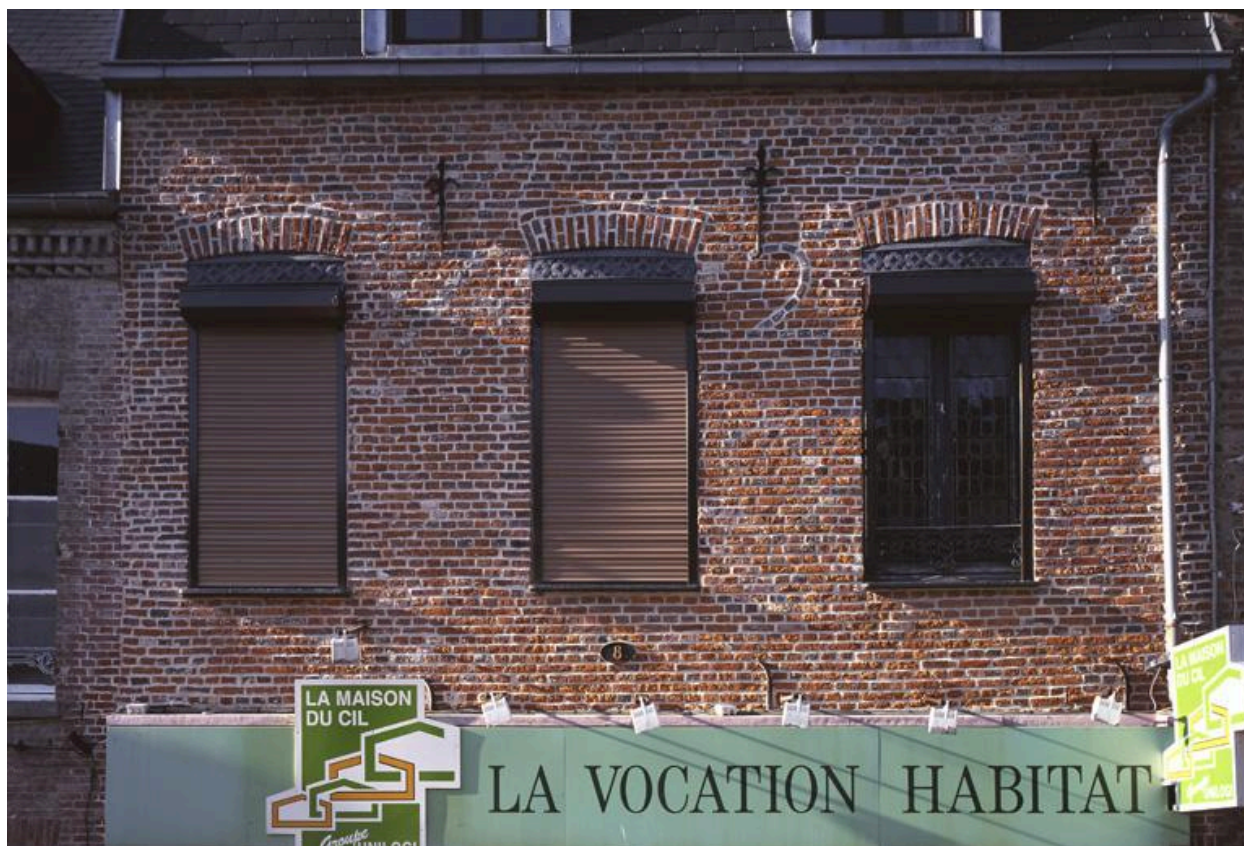
Vue de fers d'ancrage sur une maison indéterminée.
