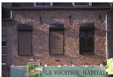
Vue de fers d'ancrage sur une maison indéterminée. Phot. Thierry Lefébure IVR22_19990206252XA
