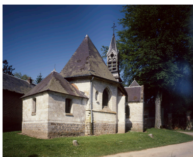
Vue du chevet. Phot. Irwin Leullier IVR22_19988000582VA
