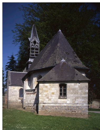
Vue du chevet. Phot. Irwin Leullier IVR22_19988000583VA
