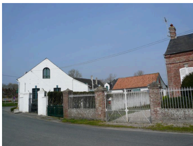
Vue des bâtiments depuis l'est. Phot. Inès Guérin IVR22_20078005707NUCA
