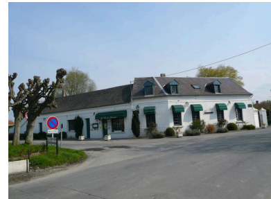
Vue générale. Phot. Inès Guérin IVR22_20078005706NUCA
