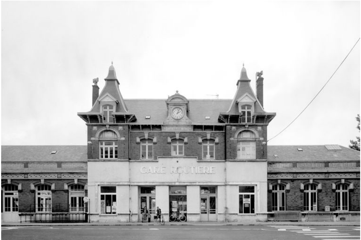
Elévation antérieure de la gare de Berck-Plage en 1981.
