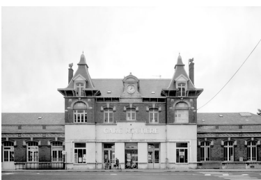
Elévation antérieure de la gare de Berck-Plage en 1981. Phot. Eric Dessert IVR31_19816203670X
