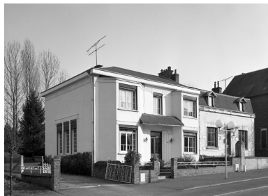
Vue générale. Phot. Thierry Lefébure IVR22_19960200095V
