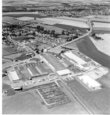
Vue aérienne, flanc sud-est.
