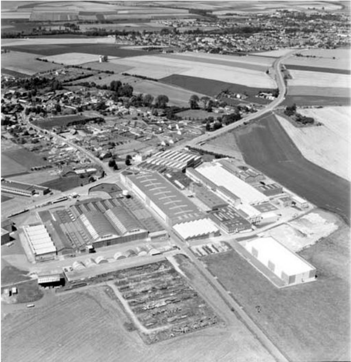
Vue aérienne, flanc sud-est.
