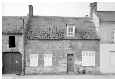
Élévation antérieure. Phot. Jean-Michel Périn IVR22_19856000796X
