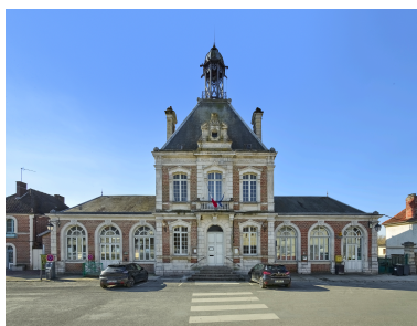
Vue de l'hôtel de ville, depuis le nord. Phot. Thierry Lefébure IVR32_20258000486NUCA
