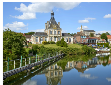
Vue de l'hôtel de ville, depuis le sud-ouest. Phot. Thierry Lefébure IVR32_20258000489NUCA
