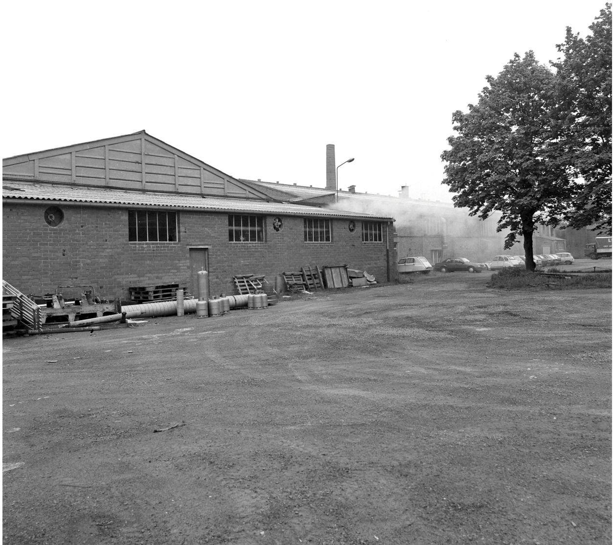
Cour vue depuis le sud-ouest.
