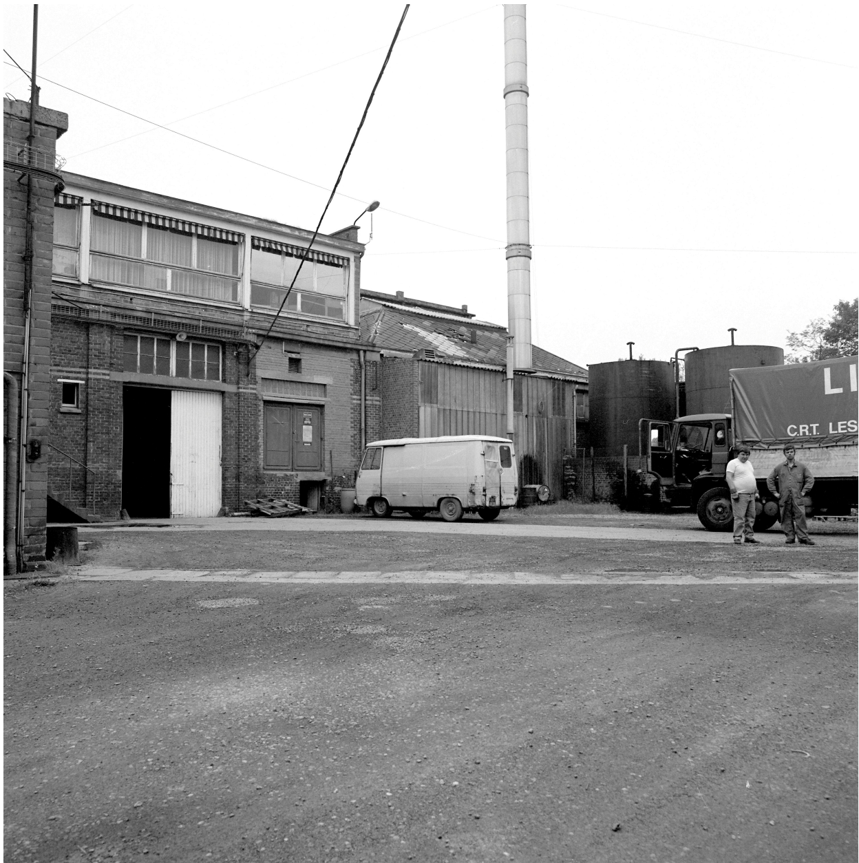
Atelier de fabrication : bureaux.
