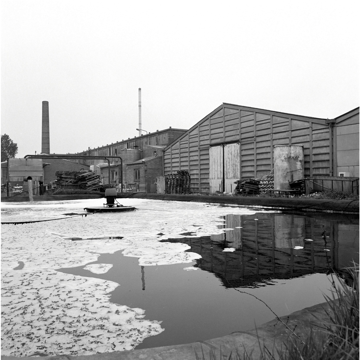
Vue d'ensemble depuis l'ouest. Bassin de décantation au premier plan, atelier de fabrication à gauche, entrepôt industriel à droite.
