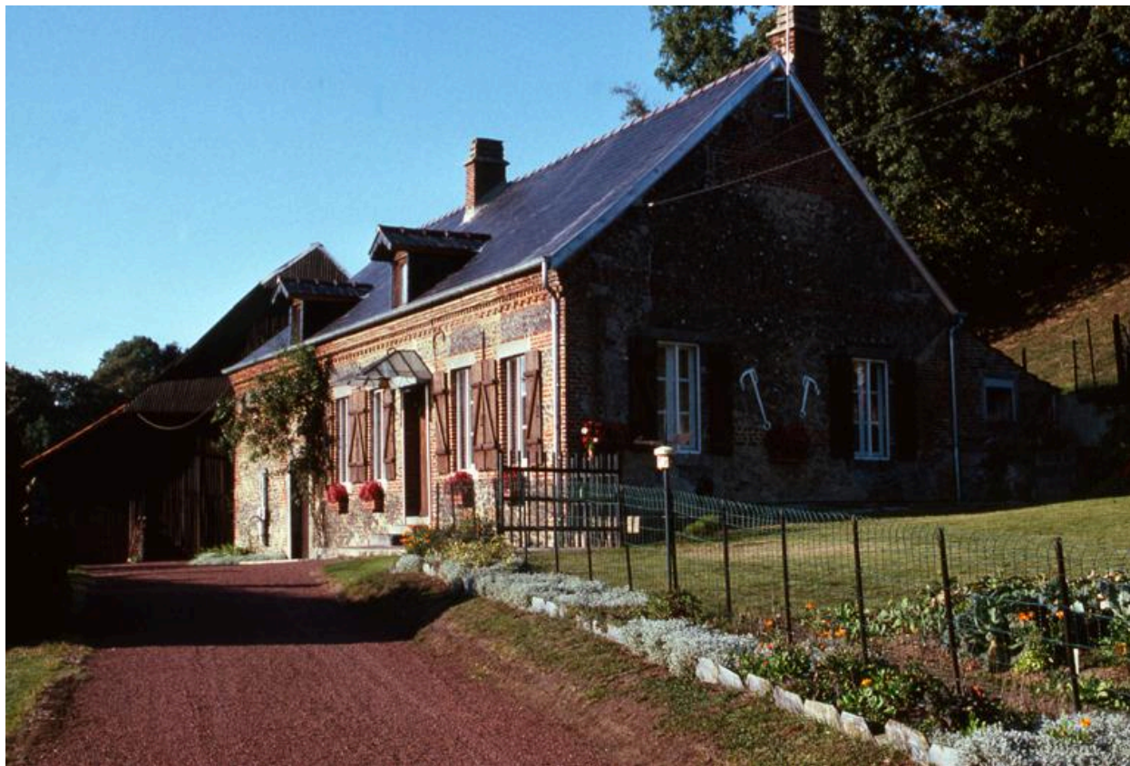
Vue d'ensemble des bâtiments, depuis le sud.
