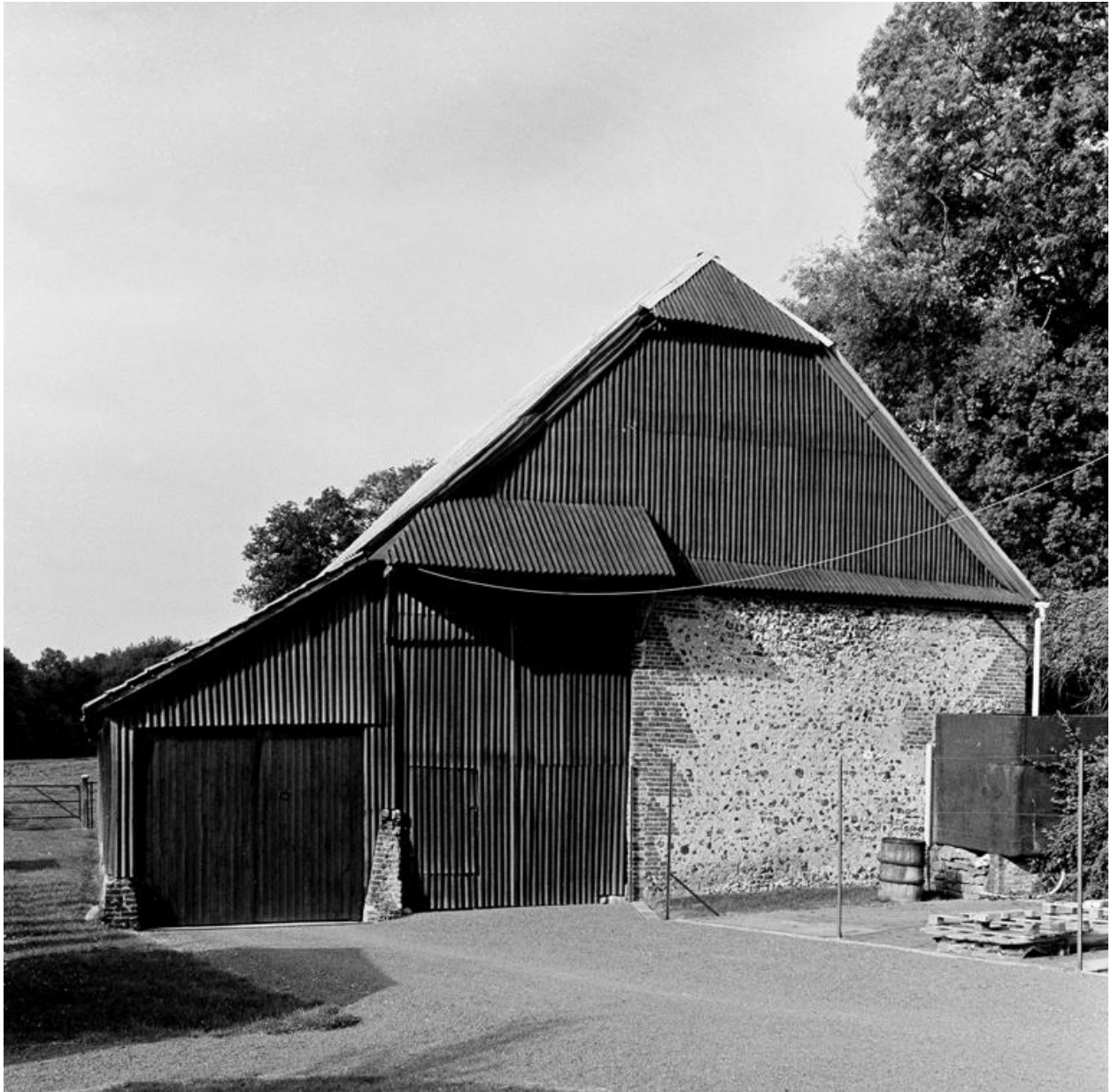
Vue de l'élévation sud de la grange.
