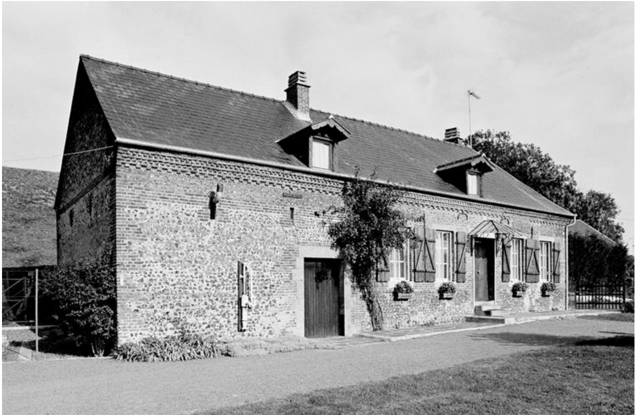
Vue d'ensemble du logis et de l'étable attenant, depuis l'ouest.
