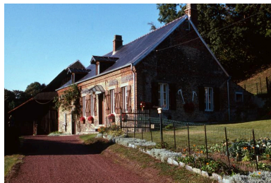
Vue d'ensemble des bâtimens, depuis le sud. Phot. Christiane Riboulleau IVR22_19900202850ZA
