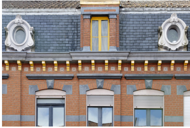
Détail de la corniche et œils-de-bœuf latéraux. Phot. Delphine Volto Jourdan IVR32_20265900034NUCA
