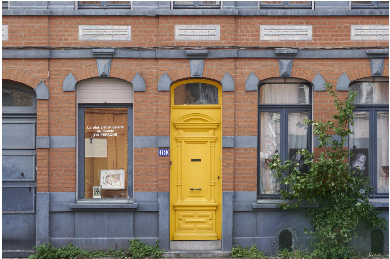
Détail de la porte et des mosaïques.
