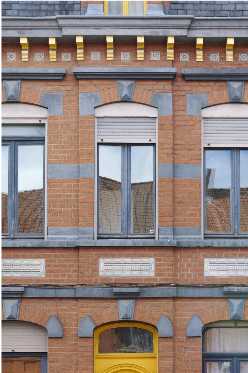
Détail d'une travée, corniche et mosaïques.
