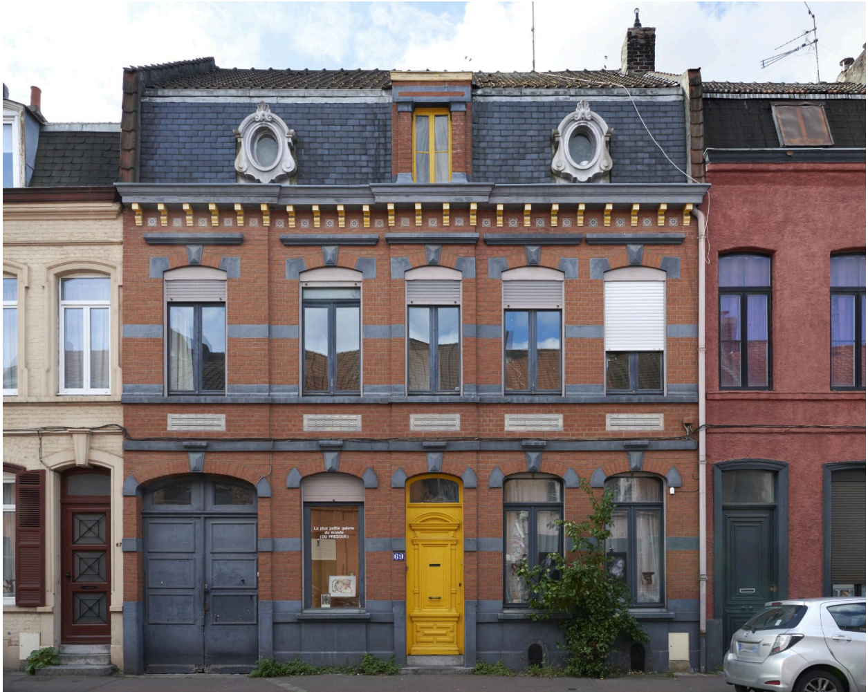
Vue générale de la façade.
