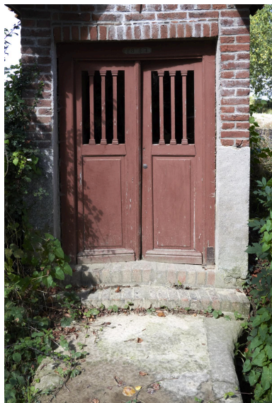
Détail de la porte et de l'entrée. Phot. Delphine Volto Jourdan IVR32_20245903015NUCA
