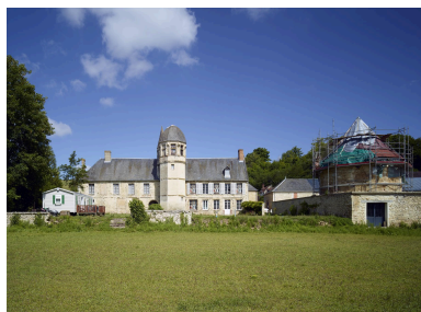
Vue de situation du colombier, en bordure du mur séparant la basse-cour du jardin du manoir. Phot. Pierre Thibaut IVR32_20250200227NUCA
