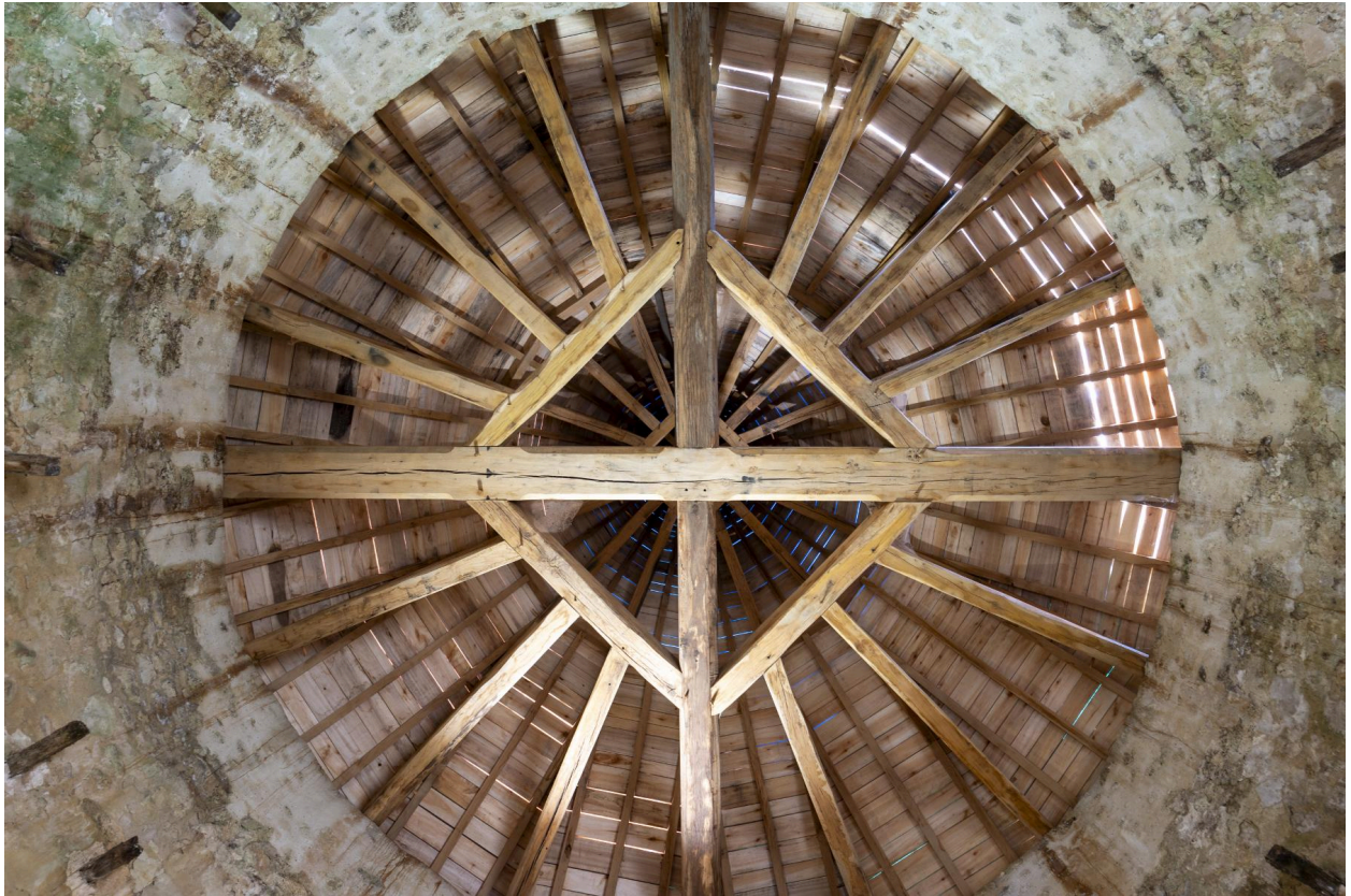
Vue en contre-plongée de la charpente du colombier.
