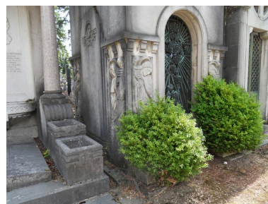
Vue de détail du décor sculpté. Phot. Isabelle Barbedor IVR22_20098010001NUCA
