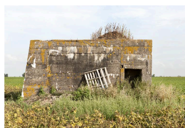
Elévation sud. Entrée Phot. Jean-Marc Ramette IVR31_20145904565NUCA
