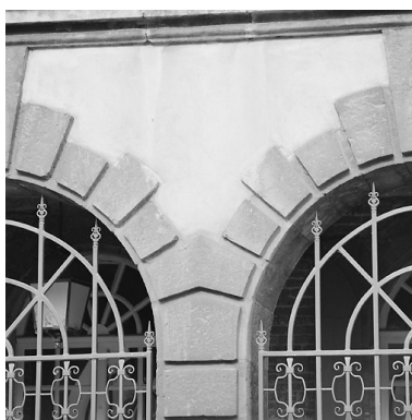
Corps de garde, façade, rez-de-chaussée, détail : encadrement des baies en bossage à table plate. Phot. Pierre Thibaut IVR31_20055900884X
