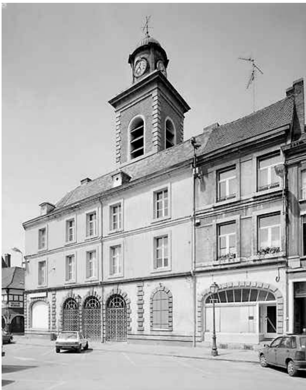
De gauche à droite : maison n° 2 rue du Collège - 26 place Pierre-Delcourt, corps de garde et beffroi, maison n° 22 place Pierre-Delcourt ; état en 2001.
