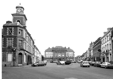
Place Pierre-Delcourt : l'hôtel de ville et le corps de garde comme éléments de structuration de la place.
