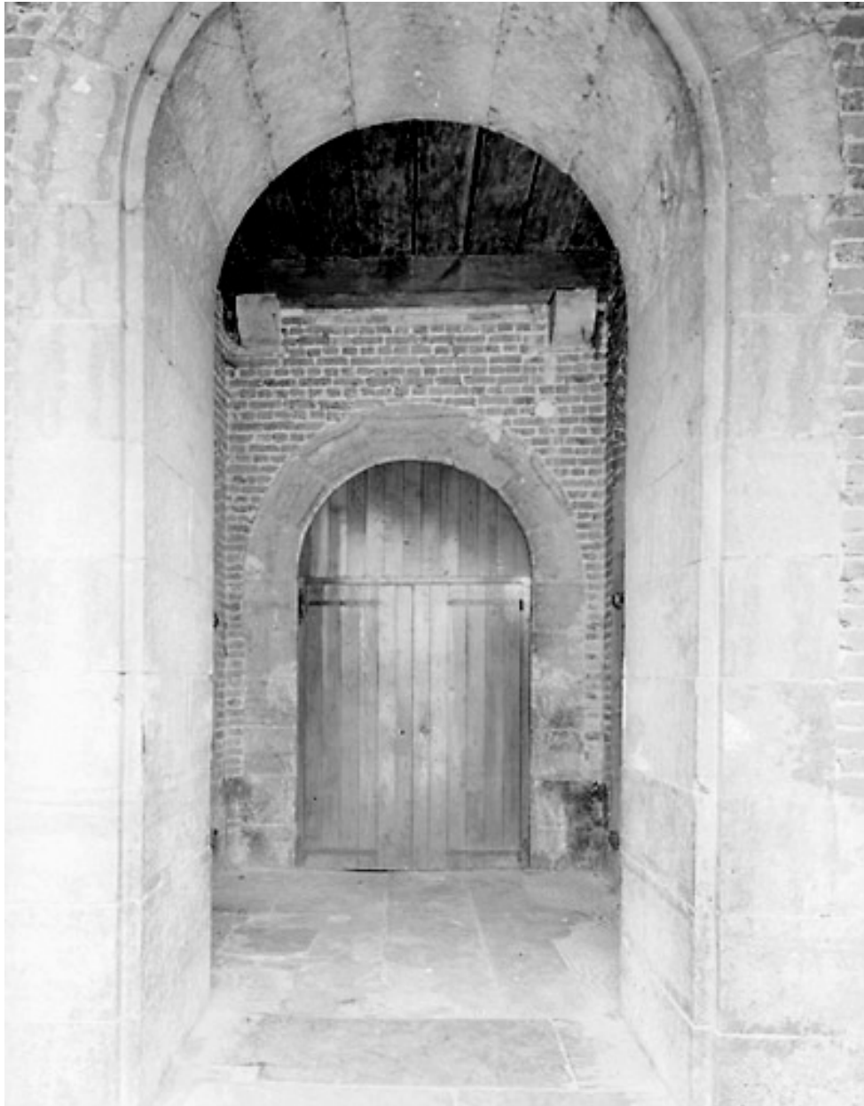
Corps de garde, intérieur, rez-de-chaussée : accès du portique vers le beffroi.
