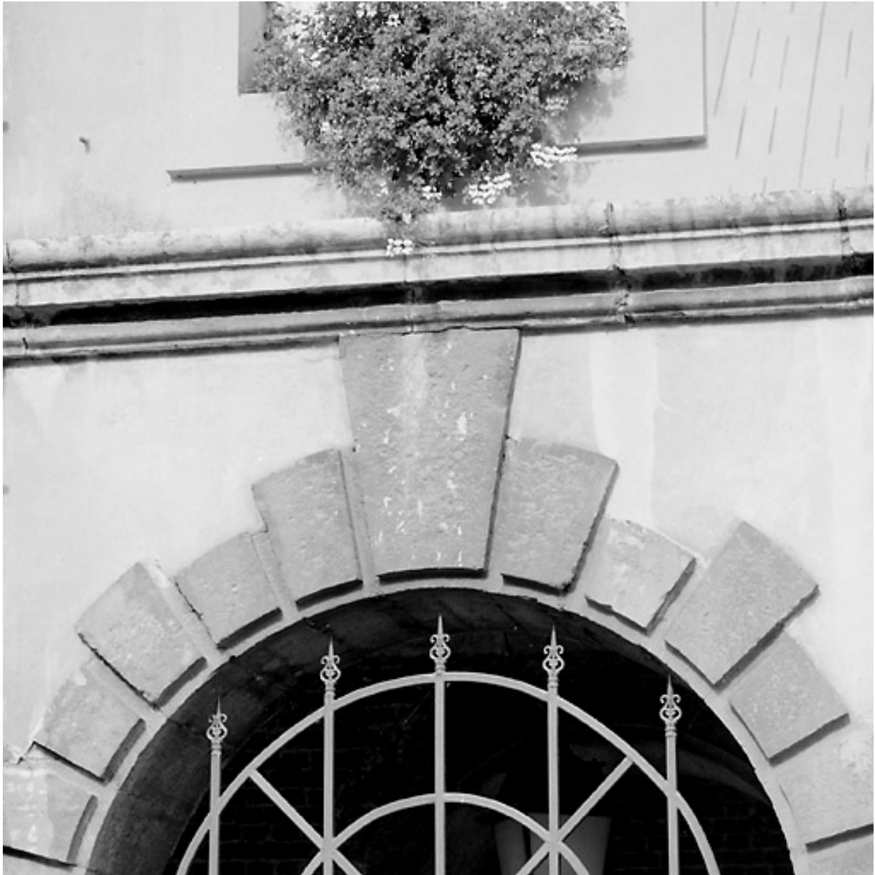
Corps de garde, façade, rez-de-chaussée : encadrement des baies en bossage à table plate.
