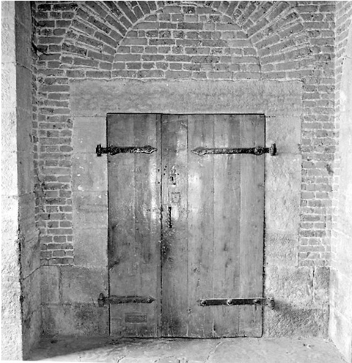
Corps de garde, intérieur, rez-de-chaussée : porte d'accès à l'ancienne salle de repos des gardes.
