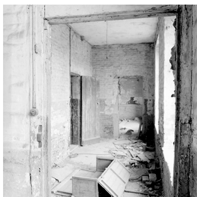
Corps de garde, intérieur, 2e étage à usage de logement : 1ère salle nord-est, état en 2005.
