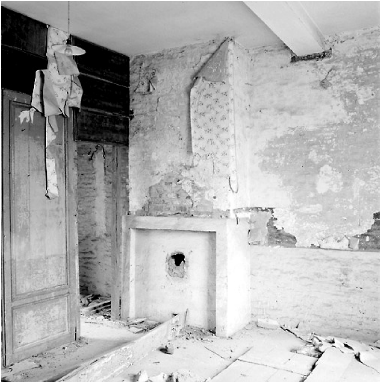
Corps de garde, intérieur, 2e étage à usage de logement : 2e salle nord-est, état en 2005.
