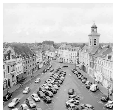
Place Pierre-Delcourt, vue depuis les combles de l'hôtel de ville : le corps de garde comme élément de structuration de la place.
