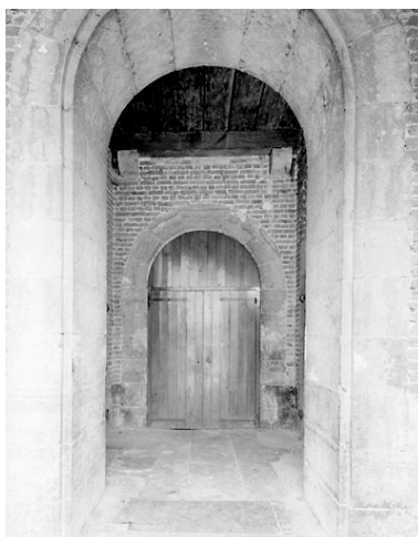
Corps de garde, intérieur, rez-de-chaussée : accès du portique vers le beffroi. Phot. Pierre Thibaut IVR31_20055900760V
