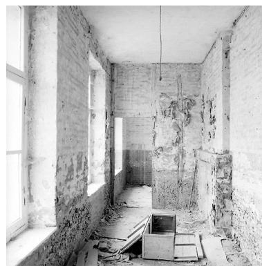
Corps de garde, intérieur, second étage à usage de logement : salle sud-ouest, état en 2005. Phot. Pierre Thibaut IVR31_20055900787X
