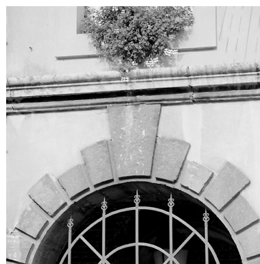
Corps de garde, façade, rez-de-chaussée : encadrement des baies en bossage à table plate. Phot. Pierre Thibaut IVR31_20055900883X
