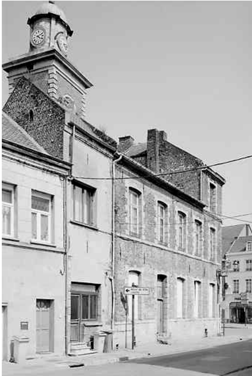
De gauche à droite : maisons portant les numéros 4 rue du Collège, 2 rue du Collège - 26 place Pierre-Delcourt ; état en 2001.
