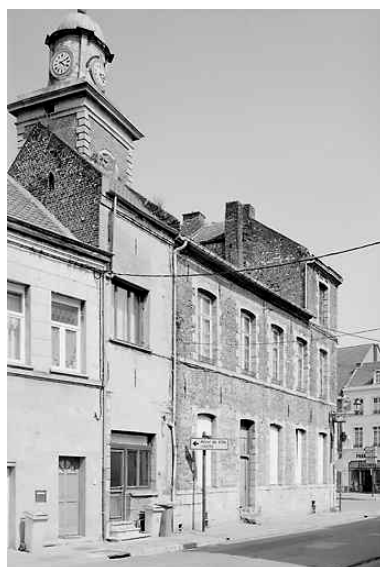
De gauche à droite : maisons portant les numéros 4 rue du Collège, 2 rue du Collège - 26 place Pierre-Delcourt ; état en 2001. Phot. Pierre Thibaut IVR31_20015901235X
