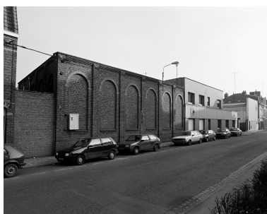
Élévation antérieure rue des Fusillés. Phot. Olivier Marlard IVR31_19915900100X
