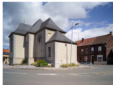
Vue générale extérieure de trois quarts depuis l'abside. Phot. Pierre Thibaut IVR31_20155901402NUCA
