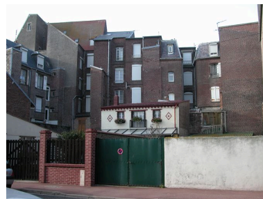
Vue des façades postérieures des maisons du front de mer, et vue de la façade principale de la maison 39 avenue du Maréchal-Foch. Phot. Elisabeth Justome IVR22_20058003440NUCA
