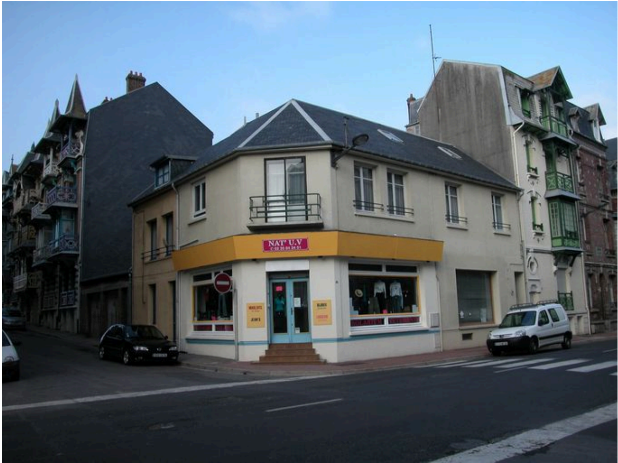
Angle de l'avenue du Maréchal-Foch et de la rue Boucher-de-Perthes.
