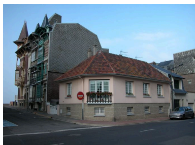
Angle de la rue Frédéric-Petit et avenue du Maréchal-Foch. Phot. Elisabeth Justome IVR22_20058003439NUCA
